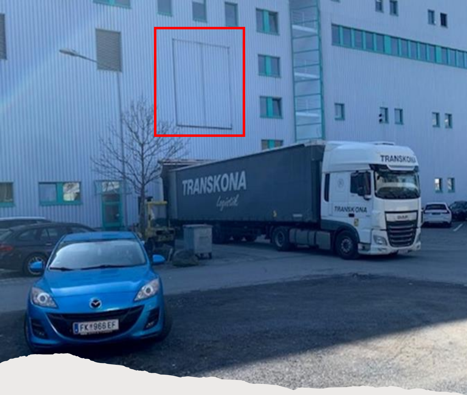
Zugangstor 1.OG für überdimensional grosse Maschinen oder Lagerware
